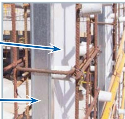
**PASSO 3:** Instalar os separadores de malha e do isolamento e os "U" de aço estrutural para garantir a separação entre as duas malhas estruturais. Finalmente é realizada a instalação das fôrmas.
