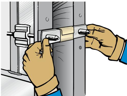
A amarra atua como um separador, permitindo obter uma parede de espessura homogênea, além de suportar a pressão de concretagem.
