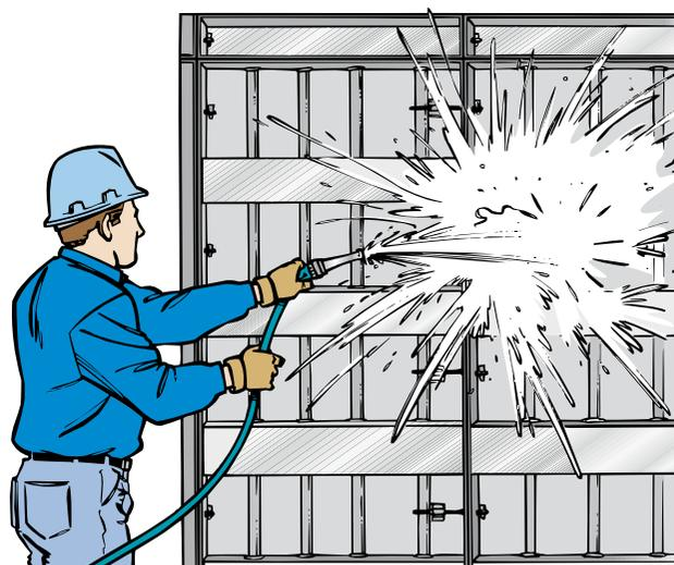
**Imediatamente após o lançamento do concreto, lave com água pressurizada o dorso das fôrmas, evitando que o concreto fique aderido. Se não houver água na obra, assegure-se de ter aplicado quantidade suficiente de ACPM (Diesel) no dorso para evitar que o concreto fique aderido à fôrma.**
