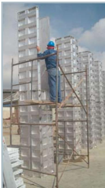
Com fôrmas em alumínio FORSA é possível fabricar todo tipo de pilar, sejam retas, circulares ou elípticas.
