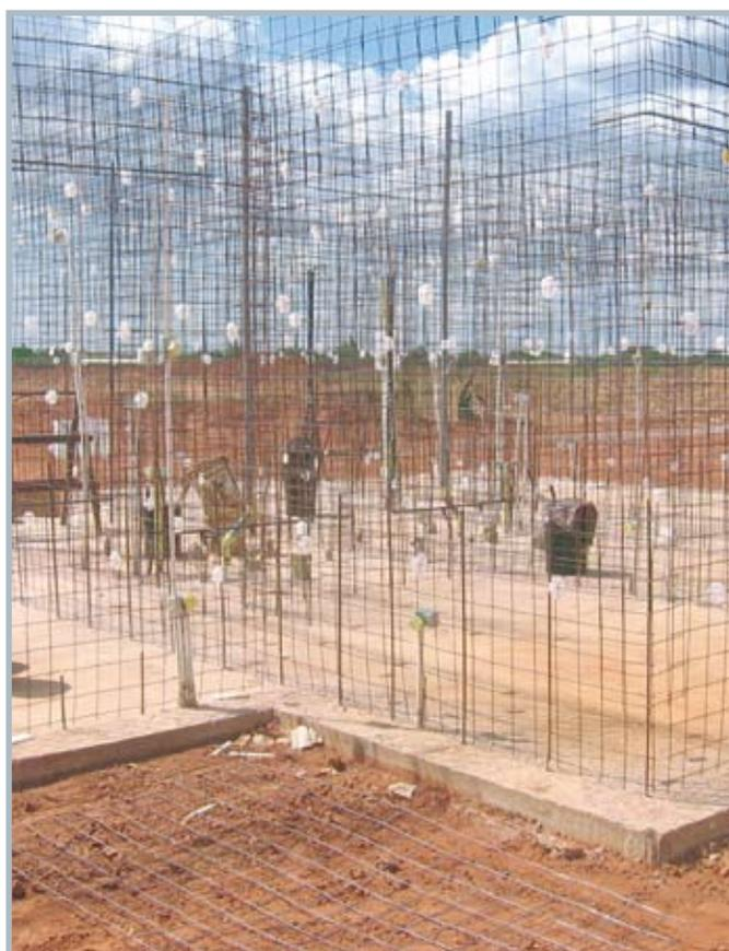
**Depois de instaladas as malhas de reforço, caixas elétricas e tubulações, faça uma revisão geral e uma boa limpeza antes de iniciar a montagem das fôrmas FORSA.**
