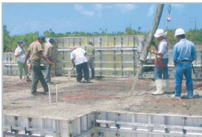
Inicie a vibração assim que o concreto começar a se estabilizar, utilizando um vibrador de agulha de 35 mm para extrair o ar do concreto.
