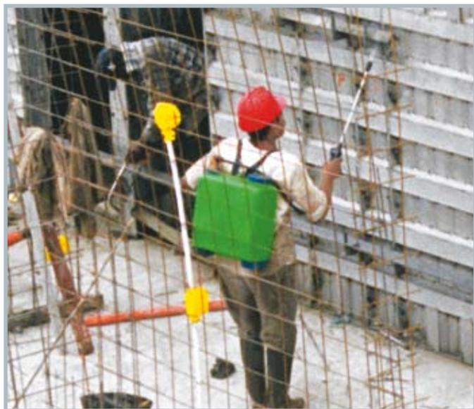
**Lembre-se de aplicar ACPM (Diesel) na parte exterior da fôrma (com máquina de aspergir ou com estopa) para evitar que o concreto fique aderido à fôrma.**
