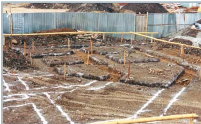
Remover a superfície vegetal, preencher com material novo até que fique compactado e nivelado.
