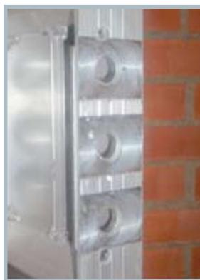
As fôrmas são reforçadas nas três perfurações do revestimento para permitir a utilização em desníveis que sejam múltiplos de 5 cm, exceto para aqueles entre uma casa e outra de 15, 45, 75 e 105 cm.
