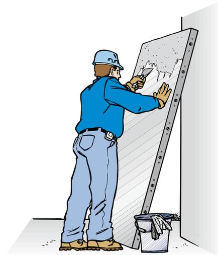
Aplice o desmoldante nos painéis antes de reutilizá-los ou guarda-los.
