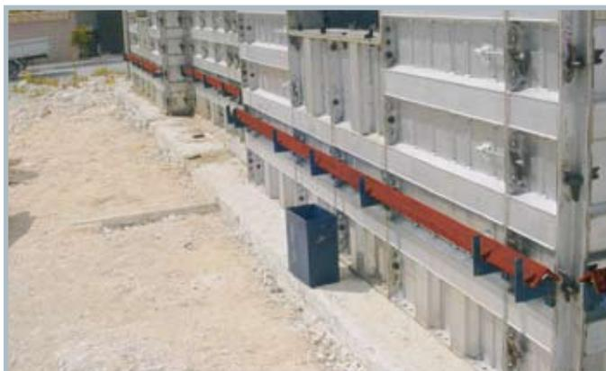
Coloque o alinhador de aço sobre os porta-alinhadores. Este alinhador é um ângulo de aço de  $2 \frac{1}{2} \times 2 \frac{1}{2} \times \frac{1}{4}$ .
