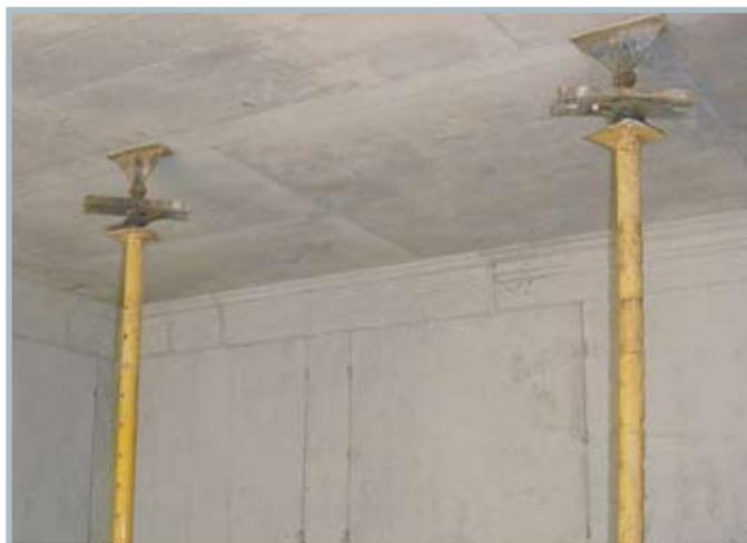
O sistema de fôrmas FORSA permite deixar escorada a laje por meio da ponteira niveladora, garantindo o escoramento da laje e a reutilização imediata de 100% das fôrmas de laje.
