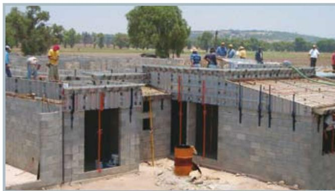
Esse sistema é baseado em um conjunto de fôrmas de laje apoiadas sobre fôrmas de transição ou complemento, cuja base é sustentada por ponteiras em todo o perímetro.
