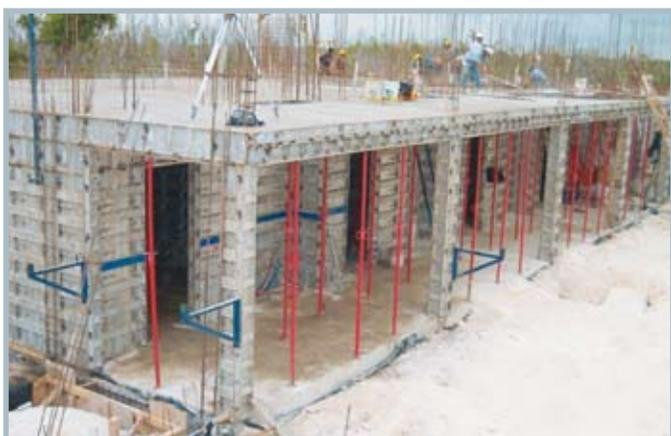
FORSA entrega painéis de transição em alumínio, os quais recebem todas as peças que conformam as vigas soltas. Posteriormente, é instalado o sistema de laje, com todo o escoramento.
