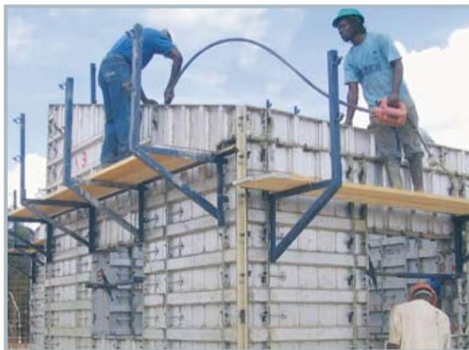
Inicie o “golpeamento” simultaneamente ao lançamento do concreto. Este consiste em golpear a parte exterior das fôrmas com um martelo de borracha para que o agregado se mova para o centro e, assim, se obtenha uma superfície melhor acabada.
