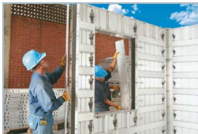
Quando o projeto requer recuos nas paredes ou em vigas de vãos, é necessária a utilização de elementos com vão negativo.
