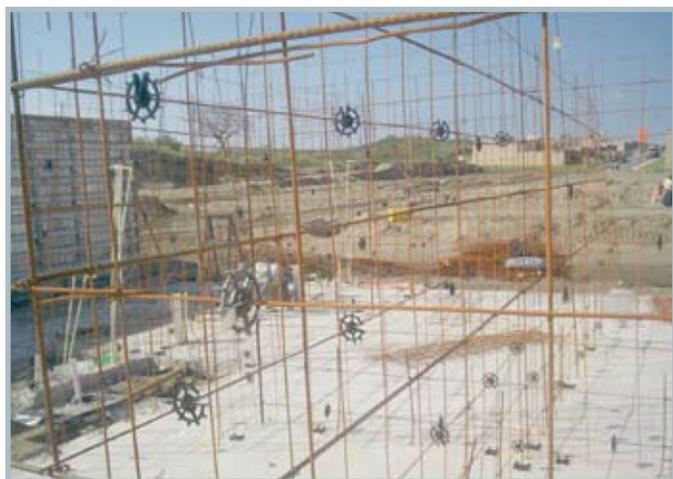
Fixe muito bem à malha as caixas elétricas e os condutores elétricos, sanitários e de gás para evitar que se desloquem ou fiquem torcidos no momento da concretagem.
