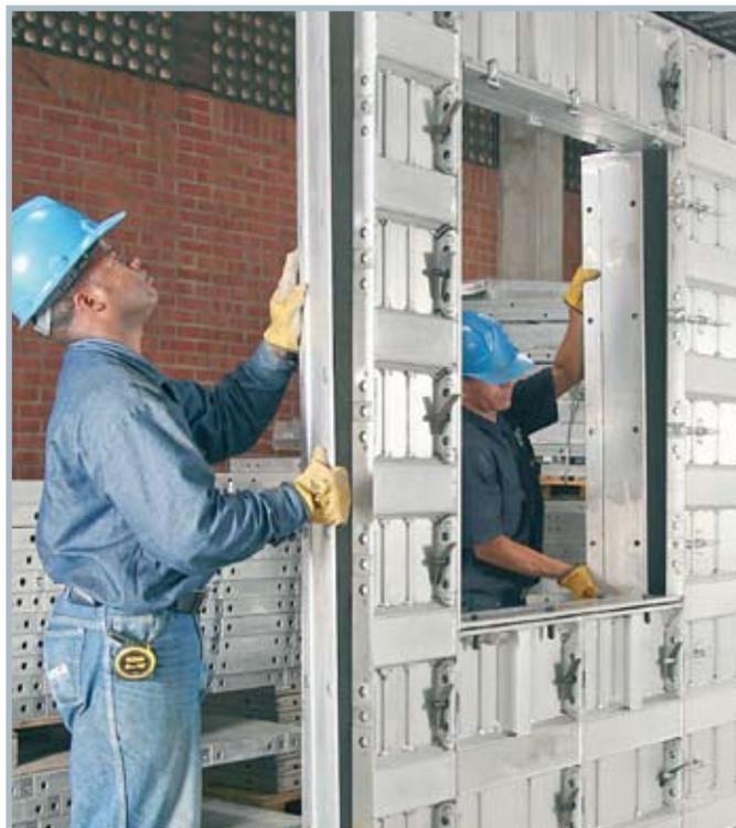
Para garantir que as portas e janelas mantenham as medidas requeridas, coloca-se o tensor.
