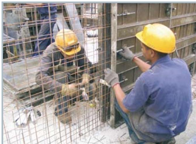
**2** Para unir uma fôrma a outra, posicione e insira o passador-flecha ou o passador-cadeado de FORSA através das perfurações das fôrmas.
