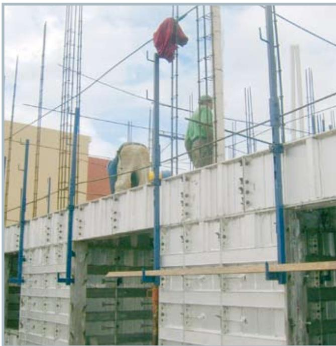
Uma vez instaladas as cabeças em todo o contorno da parede, instale os alinhadores de cabeça, assegurando-se que fiquem apurados à fôrma de parede.
