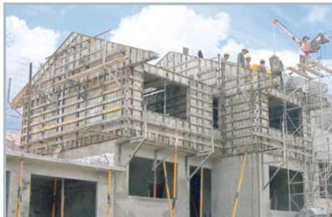
**Para um excelente prumo dos muros e culstras, é recomendado utilizar os tensores de parede especialmente desenhados para que a fôrma se acople.**
