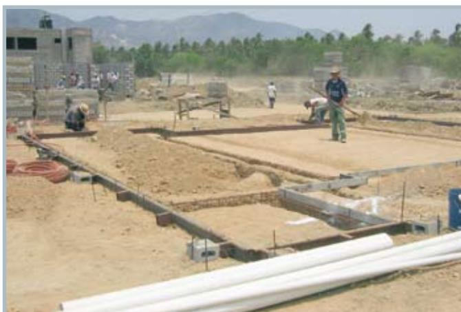
Posicionar exatamente o aço de reforço, de arranque e as instalações hidráulicas, sanitárias e elétricas.
