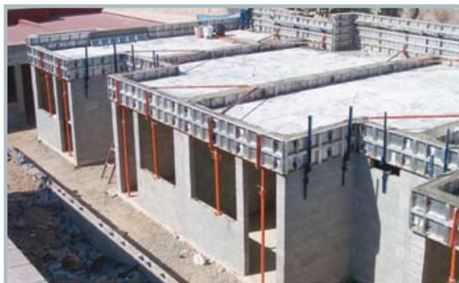
É essencial que as paredes de blocos estejam apuradas. Não se requer uma nivelção perfeita dos blocos superiores, já que está é proporcionada pelo concreto fundido.
