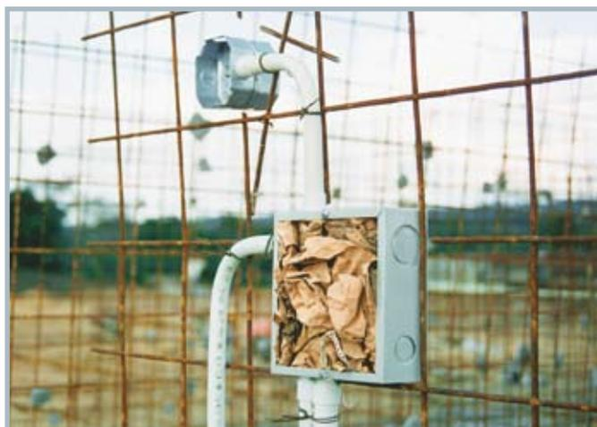
As caixas elétricas são preenchidas com papel molhado para evitar a infiltração de concreto.
