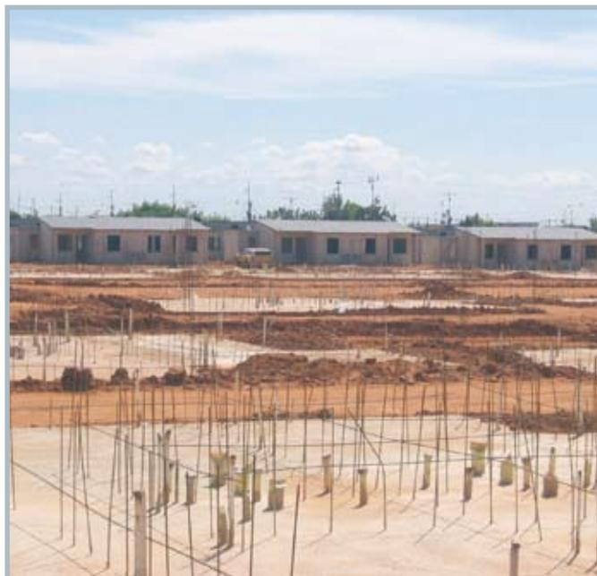
**Deve haver um cuidado especial com o espalhamento, nivelamento e acabamento da laje para facilitar a montagem das fôrmas FORSA.**
