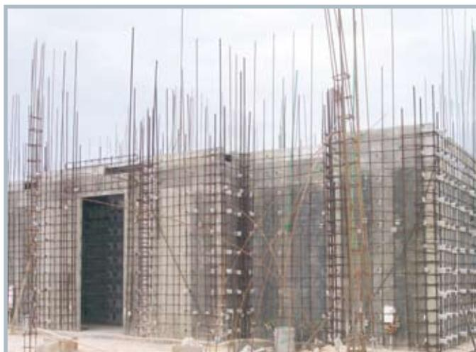
**3** Uma vez reforçado o canto, continue montando simultaneamente as fôrmas exterior de parede e as interiores, repetindo os passos 1, 2 e 3 até completar a residência.
