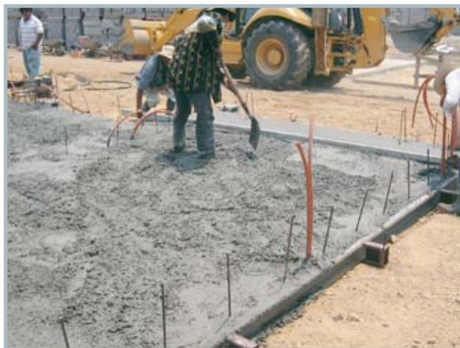
Para obter um melhor acabamento na laje, utilizar uma régua de alumínio, preferencialmente, e um vibrador durante o processo de concretagem.
