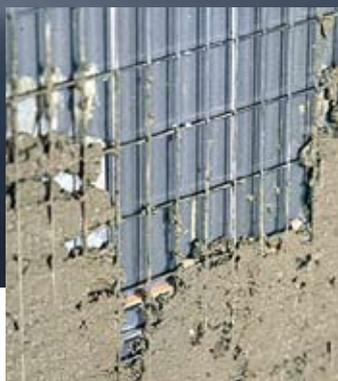
**A GRADE** que fica entre a chapa do caixilho e o limite do reboco, permite que o chapisco não saia da estrutura.
